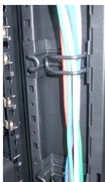
Bez-šroubová vertikální kabelová vedení v rozích (úchyty zvlášť)
