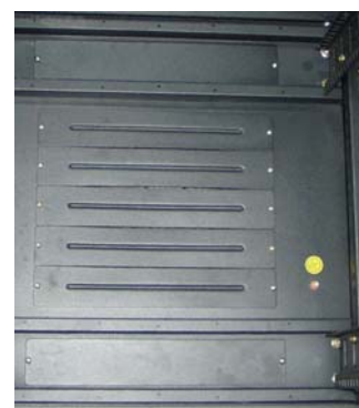
Velké kabelové prostupy, zemnicí bod
