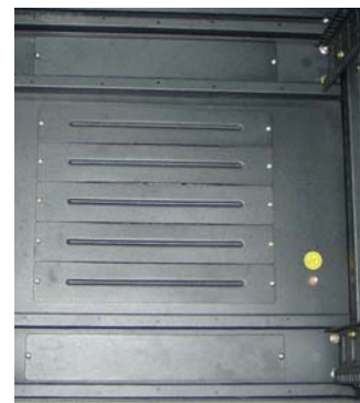
Velké kabelové prostupy, zemnicí bod
